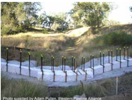
Modular sediment trap
