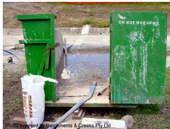
Photo 2 – Site-modified mini skip
